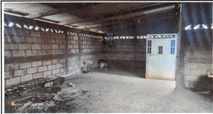
Foto1: Sustitución de lámina por lámina troquelada y estructura de soporte de madera por metal
